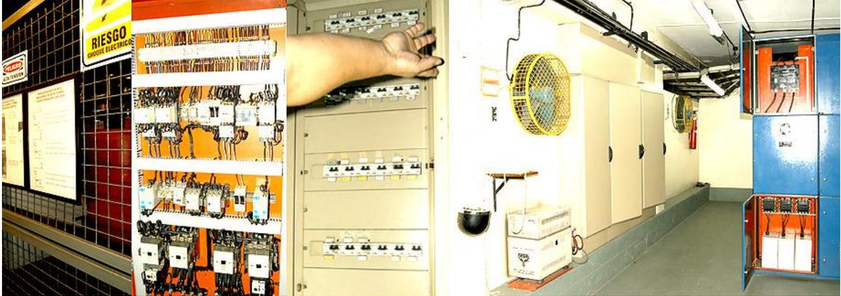
La energía eléctrica es provista a través de una cámara de transformación de 2.100 KW de capacidad, ubicada bajo nivel vereda, asegurándose así un normal suministro.
