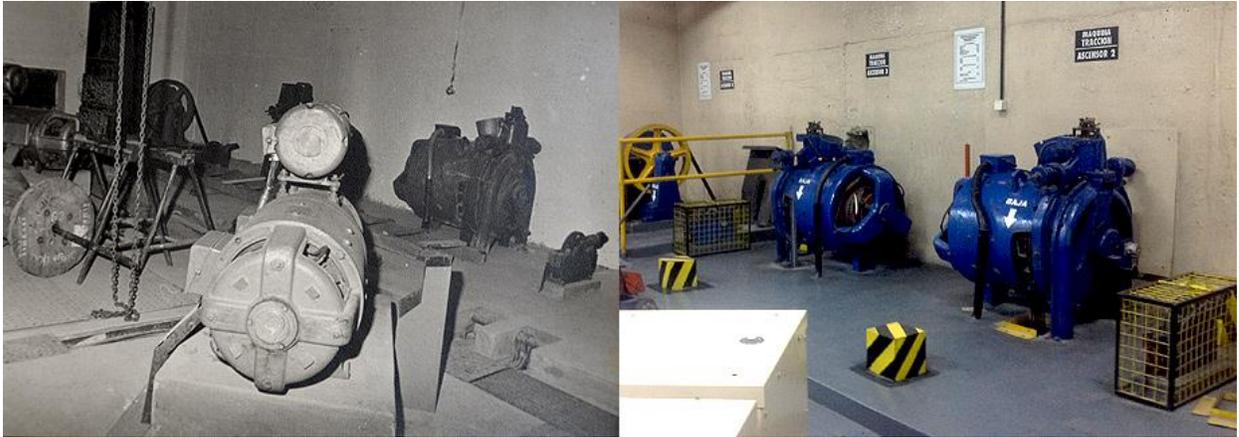
El ascensor de servicio es de 90 m/min de velocidad y 800 Kgr. de capacidad, voltaje variable, maniobra colectiva selectiva en ambas direcciones y máquina de tracción con reducción a engranajes.
